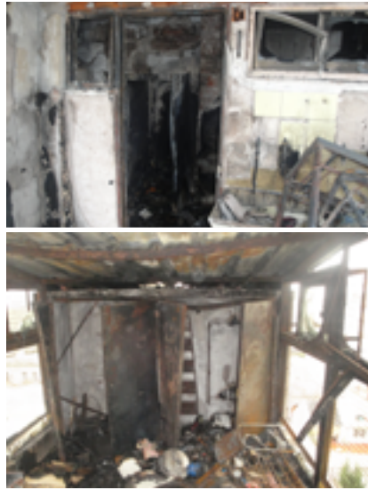
50 OBRA: ARÁOZ 1945, C.A.B.A., AGOSTO 2015. SUPERFICIE A REPARAR: 600M2 \\\
