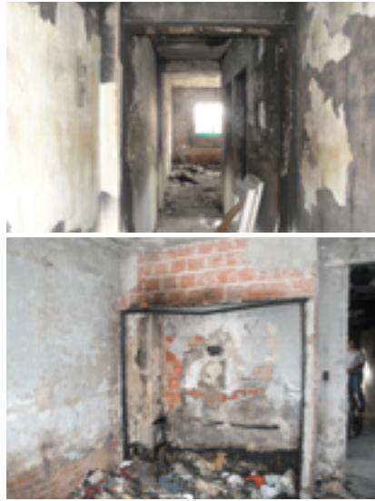
42 OBRA: ARTIGAS 1612, C.A.B.A., MAYO 2015. SUPERFICIE A REPARAR: 300M2 \\\
