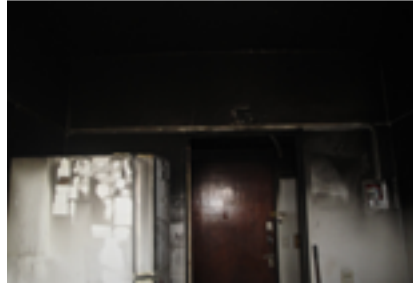
54 OBRA: GUAYRA 1810, C.A.B.A. DICIEMBRE 2015. SUPERFICIE A REPARAR: 120M2 \\\ \\ QBE SEGUROS LA BUENOS AIRES S.A.
