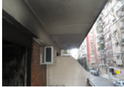
64 OBRA: LARREA 1354, C.A.B.A., JULIO 2016. SUPERFICIE A REPARAR: 250M2 \\\
